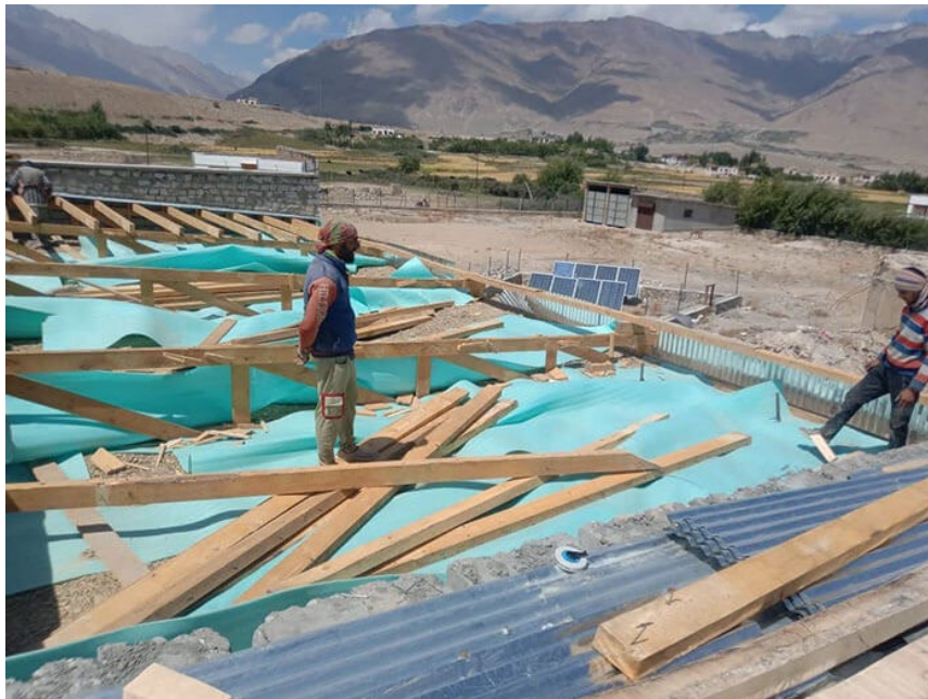
Travaux sur le toit de l'internat – septembre 2021
